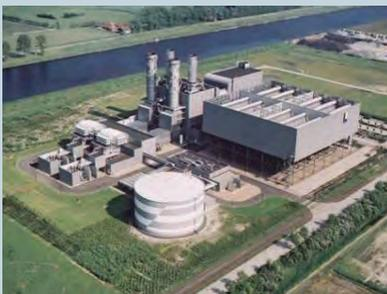
**Bruges** Бельгия — Конденсатор с воздушным охлаждением для парогазовой установки мощностью 460 МВт
