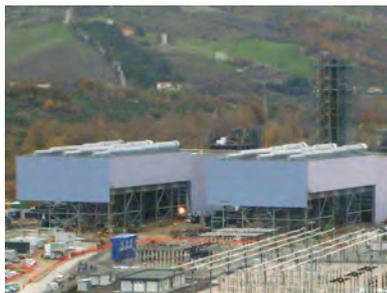
**Gissi** Италия — Конденсатор с воздушным охлаждением для парогазовой установки мощностью 2x400 МВт
