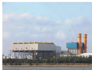
**Chang Bin** Тайвань — Конденсатор с воздушным охлаждением для парогазовых установок мощностью 490 МВт
