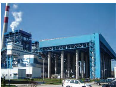
**Wuxiang** Провинция Шэньси — Конденсатор с воздушным охлаждением для угольной электростанции мощностью 2x600 МВт
