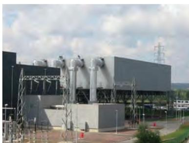
**Esch Sur Alzette** Люксембург — Конденсатор с воздушным охлаждением для парогазовой установки мощностью 360 МВт
