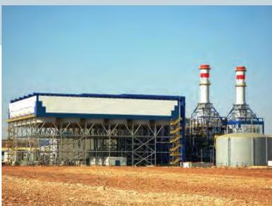
**Castelnou** Испания — Конденсатор с воздушным охлаждением для парогазовой установки мощностью 800 МВт
