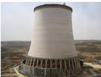
**WuAn** Китай — непрямая система сухого охлаждения для угольной электростанции мощностью 2x300 МВт.
