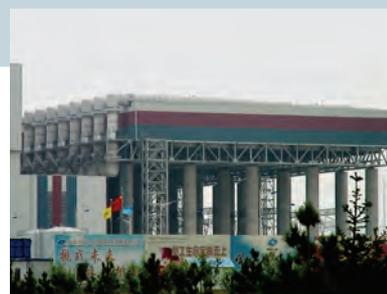
**Zhenglan** Провинция Внутр.Монголии — Конденсатор с воздушным охлаждением для угольной электростанции мощностью 4x600 МВт
