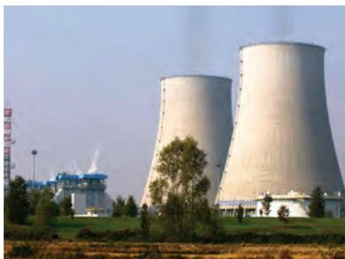
**Trino** Италия — непрямая система сухого охлаждения для парогазовой установки электростанции.
