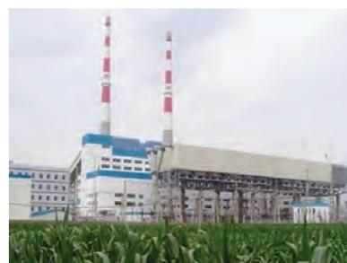
**Datong 1B** Провинция Шэньси — Конденсатор с воздушным охлаждением для угольной электростанции мощностью 4x50 МВт
