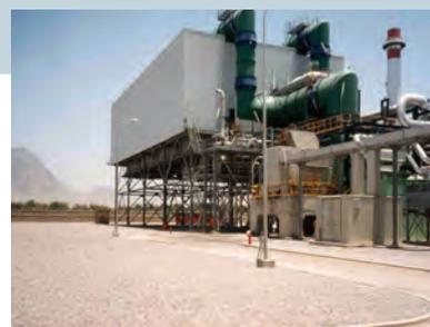
**Quetta** Пакистан — Конденсатор с воздушным охлаждением для парогазовых установок мощностью 130 МВт
