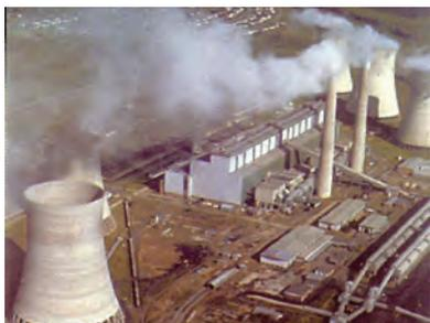
**Grootvlei** Южная Африка — непрямая система сухого охлаждения для угольной электростанции мощностью 200 МВт.
