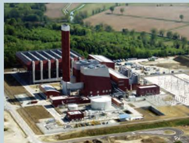
**Turano Lodigiano** Италия — Конденсатор с воздушным охлаждением для парогазовой установки мощностью 800 МВт
