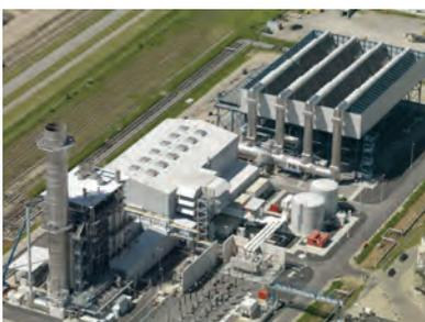
**Rijnmond** Нидерланды — Конденсатор с воздушным охлаждением для парогазовой установки мощностью 430 МВт
