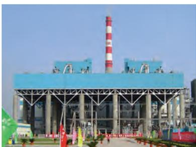
**Zhangshan** Провинция Шэньси — Конденсатор с воздушным охлаждением для угольной электростанции мощностью 2x600 МВт
