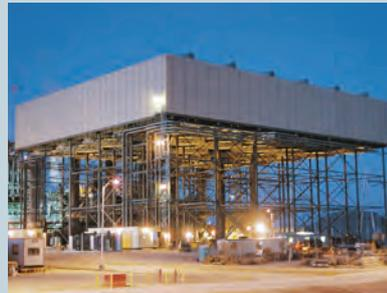
**Апекс** Невада, США — Конденсатор с воздушным охлаждением для парогазовой установки мощностью 500 МВт
