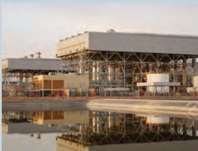
**Riyadh** Саудовская Аравия — Конденсатор с воздушным охлаждением для парогазовой установки мощностью 2x850 МВт
