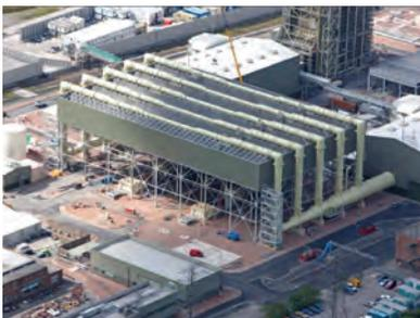
**Severn** Великобритания — Конденсатор с воздушным охлаждением для парогазовой установки мощностью 2x400 МВт
