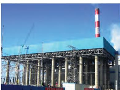
**Dalate** Провинция Внутр.Монголии — Конденсатор с воздушным охлаждением для угольной электростанции мощностью 2x600 МВт
