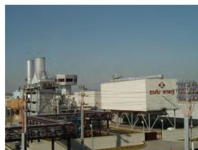
**Bursa** Турция — Конденсатор с воздушным охлаждением для парогазовых установок мощностью 55 МВт
