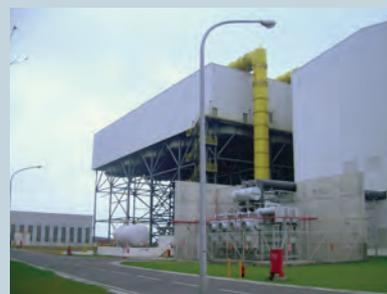
**Star Buck** Тайвань — Конденсатор с воздушным охлаждением для парогазовых установок мощностью 490 МВт
