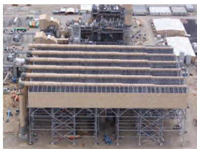
**Colusa** Калифорния, США — Конденсатор с воздушным охлаждением для парогазовой установки мощностью 660 МВт
