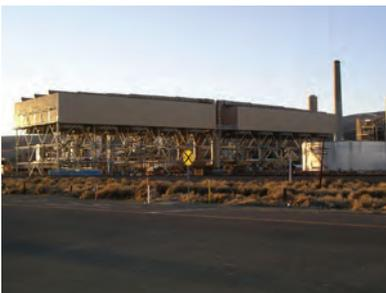
**Траси** Невада, США — Конденсатор с воздушным охлаждением для парогазовой установки мощностью 500 МВт
