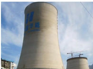
**Qinling** Китай — непрямая система сухого охлаждения для угольной электростанции мощностью 2x600 МВт.
