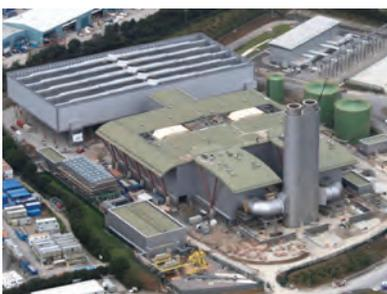
**Langage** Великобритания — Конденсатор с воздушным охлаждением для парогазовой установки мощностью 850 МВт
