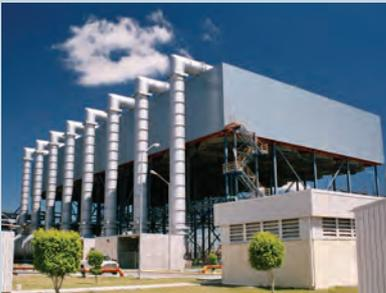
**Rio Bravo** Чиуауа, Мексика — Конденсатор с воздушным охлаждением для парогазовой установки мощностью 3x515 МВт
