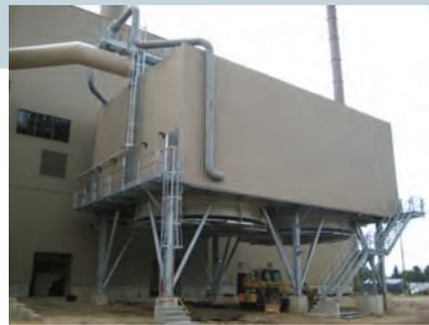
**Olmsted** Миннесота, США - с воздушным охлаждением конденсатора на 15 МВ отходов мусоросжигательного завода
