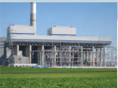
**Baicheng** Провинция Цзилинь — Конденсатор с воздушным охлаждением для угольной электростанции мощностью 4x600 МВт
