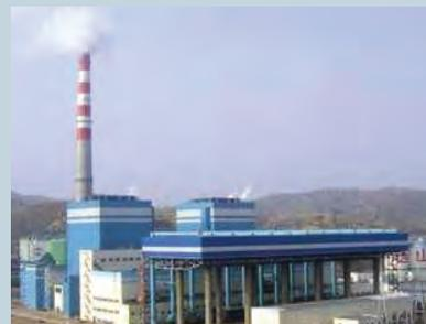
**Gujiao** Провинция Шэньси — Конденсатор с воздушным охлаждением для угольной электростанции мощностью 2x300 МВт
