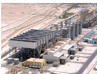
**Alba** Бахрейн — Конденсатор с воздушным охлаждением для парогазовых установок мощностью 820 МВт
