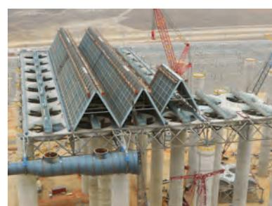
**Kusile** Южная Африка — Конденсатор с воздушным охлаждением для угольной мощностью 6x740 МВт электростанции
