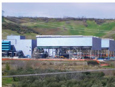
**Scandale** Великобритания — Конденсатор с воздушным охлаждением для парогазовой установки мощностью 2x400 МВт
