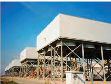
**Midlothian** Техас, США — Конденсатор с воздушным охлаждением для парогазовой установки мощностью 6x250 МВт
