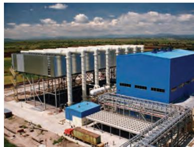
**El Sauz** Керетаро, Мексика — Конденсатор с воздушным охлаждением для парогазовой установки мощностью 350 МВт
