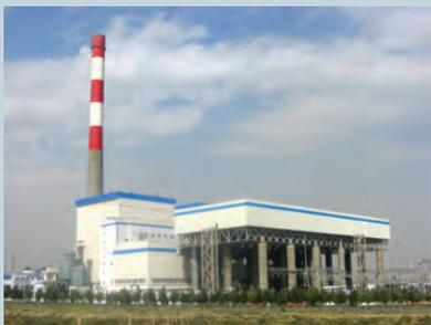
**Haibowan** Провинция Внутр.Монголии — Конденсатор с воздушным охлаждением для угольной электростанции мощностью 2x200 МВт
