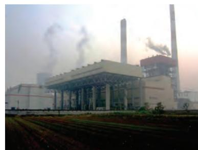
**Heijin** Провинция Шэньси — Конденсатор с воздушным охлаждением для угольной электростанции мощностью 2x300 МВт
