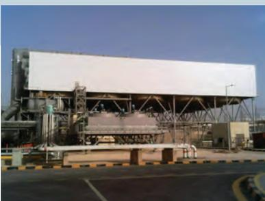
**Amman** Иордания — Конденсатор с воздушным охлаждением для парогазовых установок мощностью 400 МВт
