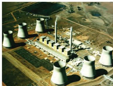
**Kendal** Южная Африка — непрямая система сухого охлаждения для угольной электростанции мощностью 6x690 МВт.
