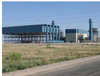
**Hobbs** Нью-Мексико, США — Конденсатор с воздушным охлаждением для парогазовой установки мощностью 500 МВт
