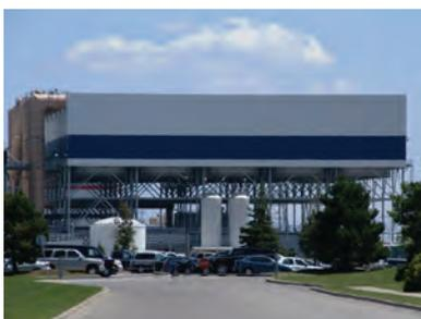
**Goreway** Онтарио, Канада — Конденсатор с воздушным охлаждением для парогазовой установки мощностью 800 МВт
