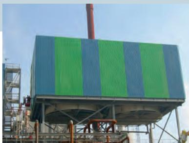
**St. Gaudens** Франция — Конденсатор с воздушным охлаждением для биомассовой установки мощностью 10 МВт
