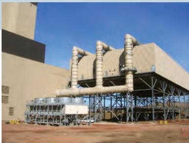
**WyGen 3** Вайоминг, США — Конденсатор с воздушным охлаждением для угольной электростанции мощностью 110 МВт
