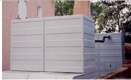
Le torri di raffreddamento serie MCT, costruttivamente basate sul comune concetto di incorrodibilità che contraddistingue tutta la gamma MITA, offrono una soluzione principalmente caratterizzata da alta qualità dei materiali e basso livello di rumorosità, ulteriormente riducibile mediante l'installazione di silenziatori fonoassorbenti.
